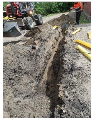
Pihatien poikkileikkaus. Pihatien poikki kaivettu oja. Vanha pikipäällyste tien kohdalla. Itään.
