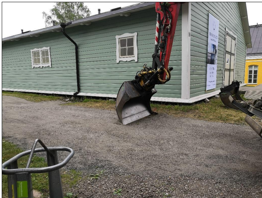
Ojan I kaivuutyö alkamassa.
