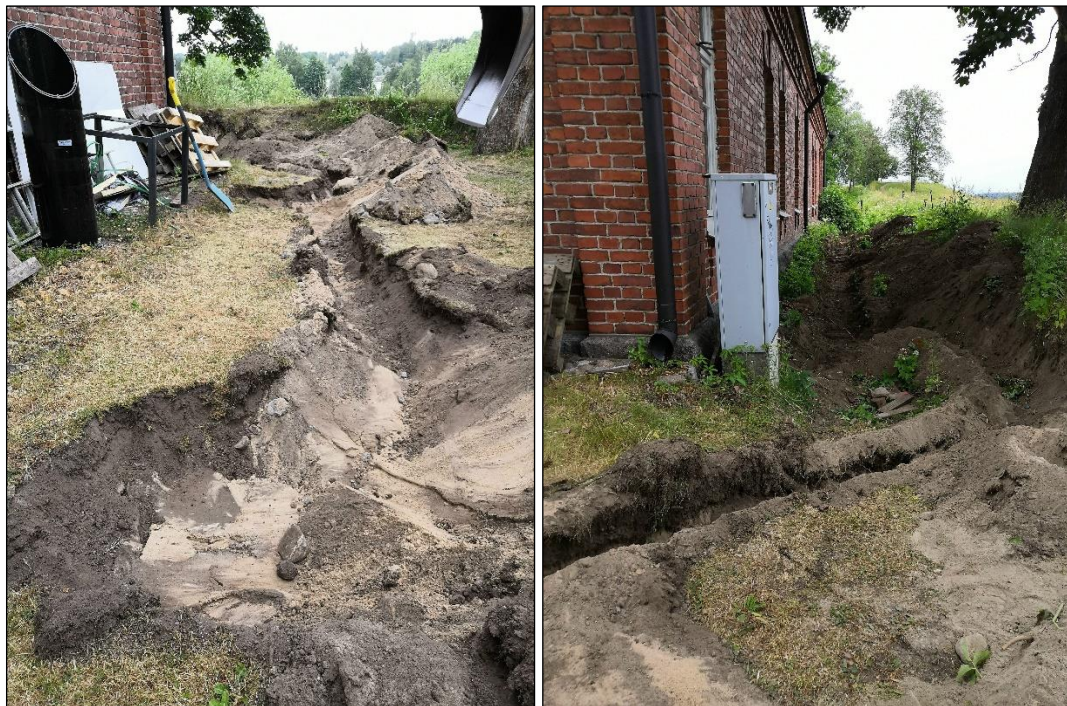
Vasen. Oja J valmis. Maaperä oli rakennuksen eteläpäädyssä pintanurmen alla hienoa hiekkaa. Kuvasuunta itään. Oikea. Oja J valmis, rakennuksen itäseinusta, kuvaussuunta pohjoiseen.
