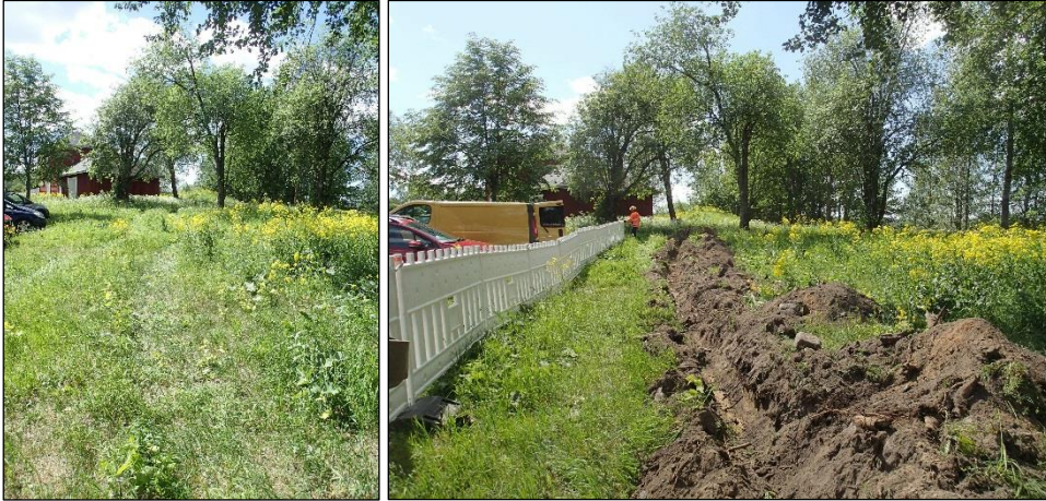
Vasen. Kaapellinjaa ennen kaivua metsäpuiston poikki kohti punaista rakennusta. Lounaaseen. Oikea. Kaivettu kaapelioja metsäpuiston kohdalla. Etelään.
