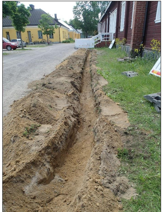
Vasen. Kaivettua kaapeliojaa eteläpäässä. Oikea. kaivettu ojaa keskivaiheilla.
