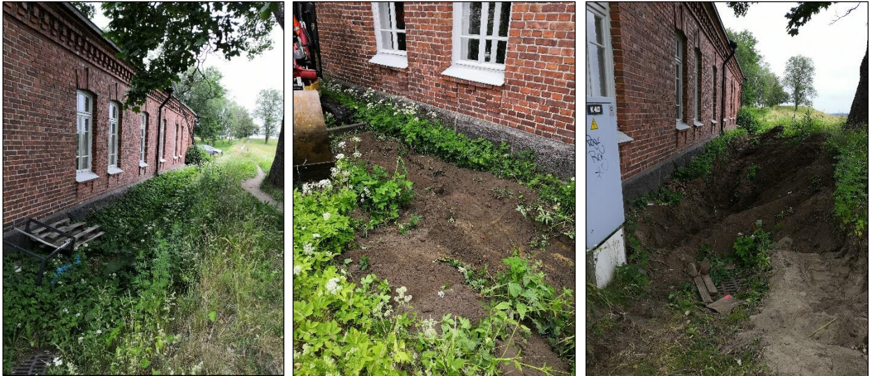
Vasen. Ojan J paikka Krouvin itäseinustalla ennen kaivuutyön aloitusta. Kuvasuunta pohjoiseen. Keskellä. Rakennuksen itäseinustalla multamaannoksen alapuolella oli havaittavissa hiekkaa. Oikea. Oja J rakennuksen itäseinustalla, oja kiertää sadevesiviemärin vallin puolelta.
