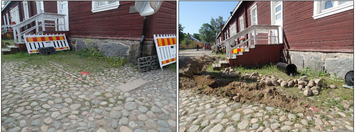
Vasen. Kiveystä rakennuksen pohjoispäässä. Oikea. Kaapelioja kaivettu kiveyksen kohdalle.
